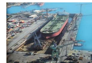
Les travaux en forme de radoub
