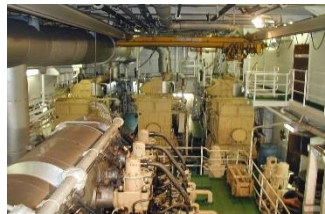
Feux dans les locaux techniques
